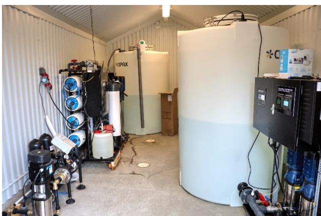
Avsaltningsaggregat på Aspöja
